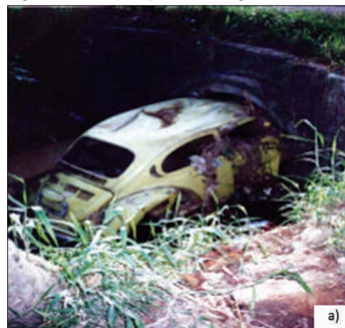
Figura 5: a) Obstrução à drenagem
